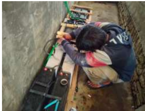
Gambar 8. Pemasangan Baterai
