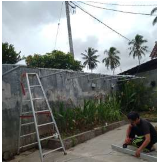
Gambar 4. Pembuatan Rangka galvalum
