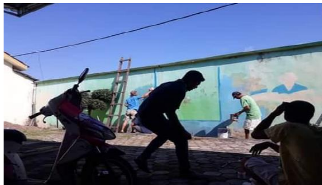
Gambar 6 Pembangunan Tahap III ( Finishing )
