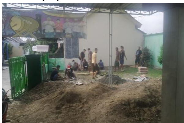
Gambar 5 Pembangunan Tahap II (Pengecoran)
