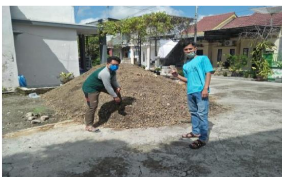
Gambar 4 Pembangunan Tahap I
