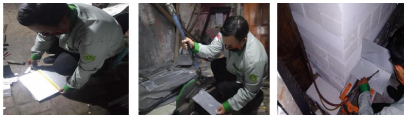
Gambar 7. Pengukuran, Pemotongan dan Pengelasan Plat Stainlees
